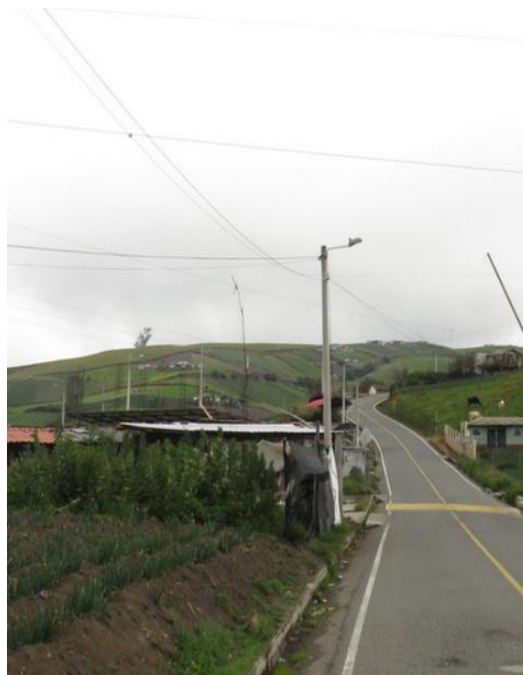
Fotografía 10.- Red de energía eléctrica
